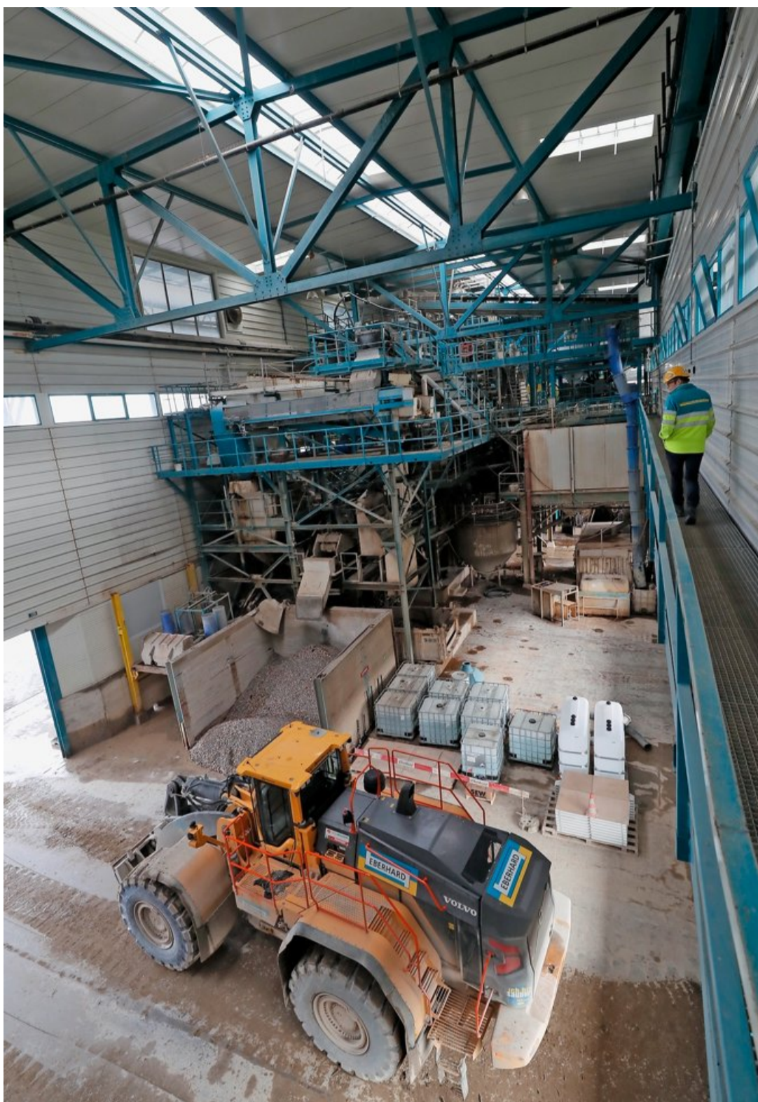
In der grössten Anlage dieser Art in der Schweiz wurden in den 25 Jahren Betrieb etwa fünf Millionen Tonnen Material wiederaufbereitet.
